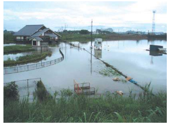
曾我川保田浄化施設付近（平成19年7月17日出水）
