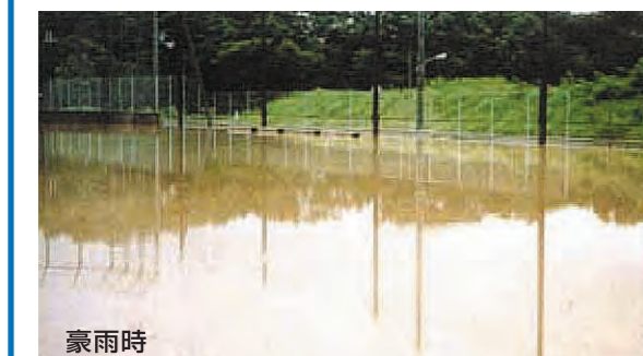
雨水貯留浸透施設 敷地内に降った雨は学校のグラウンドや駐車場を利用して、一時的に貯留します。
