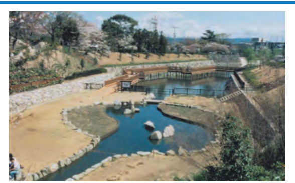
ため池の治水利用 地域の保水機能を高めるため、大雨時に、より多くの水を貯められるよう既存のため池施設を一部改良することで、洪水時に下流域の負担を軽減します。
