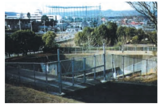
防災調整池 宅地造成等の市街地開発では河川への流出量が増大するため、防災調整池によって雨水を一時的に貯留し、流出を抑制します。
