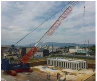
令和2年6月 貯留施設敷設工
