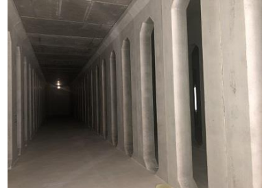
令和2年8月 貯留施設敷設完了
