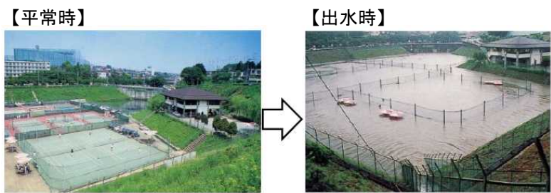
雨水貯留浸透施設の例(防災調整池)
