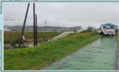
千代川水系清水川 (鳥取県鳥取市) (国土交通省の排水ポンプ車による排水)
