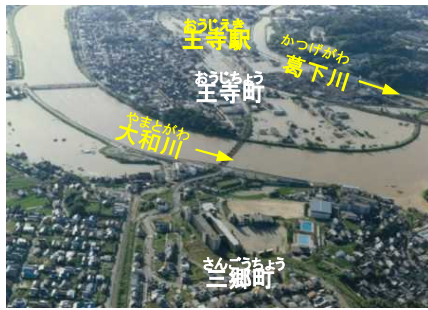
王寺町 葛下川合流点の浸水状況 (大和川27.0k付近)
