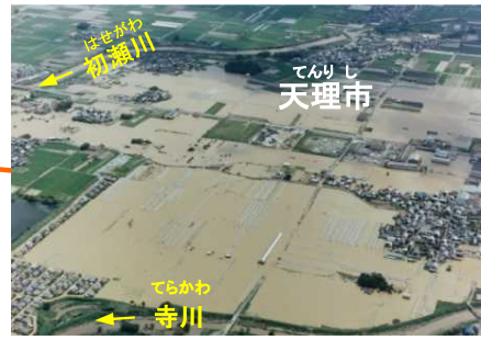
天理市 庵治町の浸水状況 (初瀬川3.0k・寺川3.0k付近)
