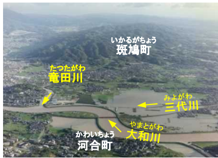
斑鳩町 竜田川合流点の浸水状況 (大和川31.0k付近)
