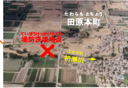
田原本町 堤防決壊地点の浸水状況 (初瀬川5.0k付近)
