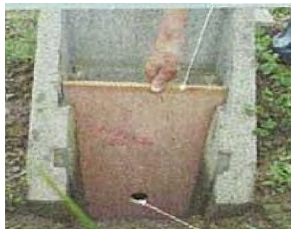
排水柵の改良
