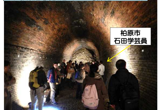
旧大阪鉄道亀瀬隧道（レンガ積鉄道トンネル跡）
