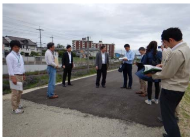
河道掘削事業箇所
