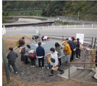
集水井を上から見ると・・・
