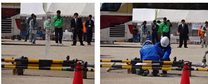
水道管復旧訓練
