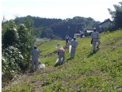
河川維持業者による堤防法面の清掃
