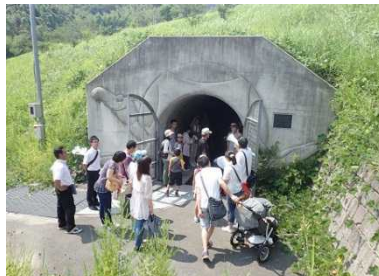
排水トンネル入り口
