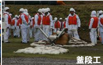
越水止水のう工
