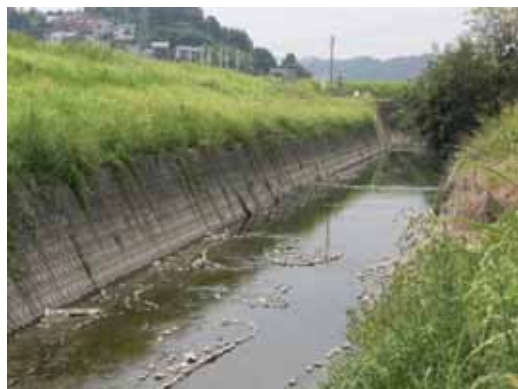
【三代川浄化施設(薄層流浄化法)】
