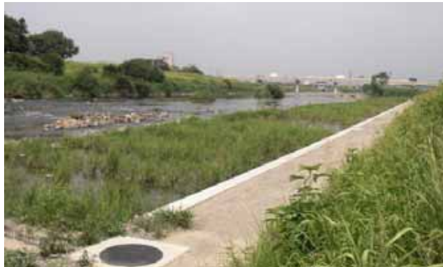
【不毛田浄化施設(植生浄化施設)】
