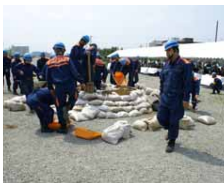
漏水対策工の実演訓練 (泉州水防事務組合水防訓練)
