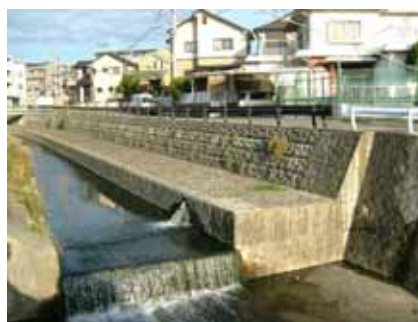
写真 東生駒総合浄化施設(排水口)
