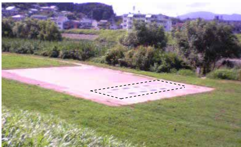
写真 南浦樋門浄化施設(プラスチック製接触材による浄化、H19.3 完成) (舗装箇所の高水敷の中に埋設)
