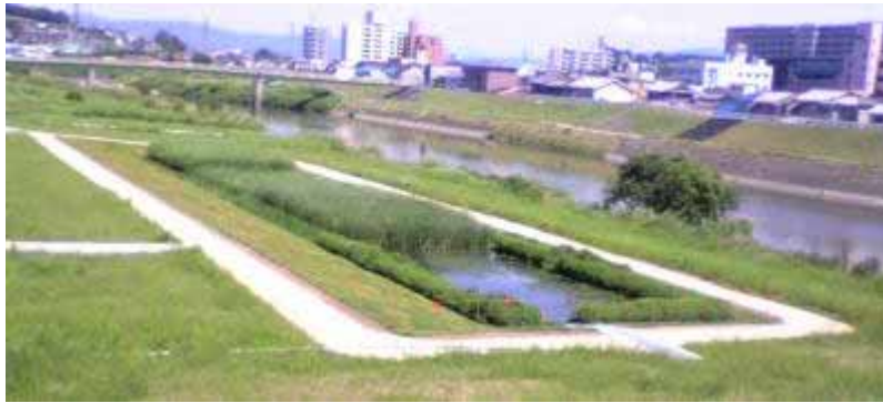
写真 信貴川浄化施設(ヨシ、ガマ、木炭等による浄化、H19.3 完成)
