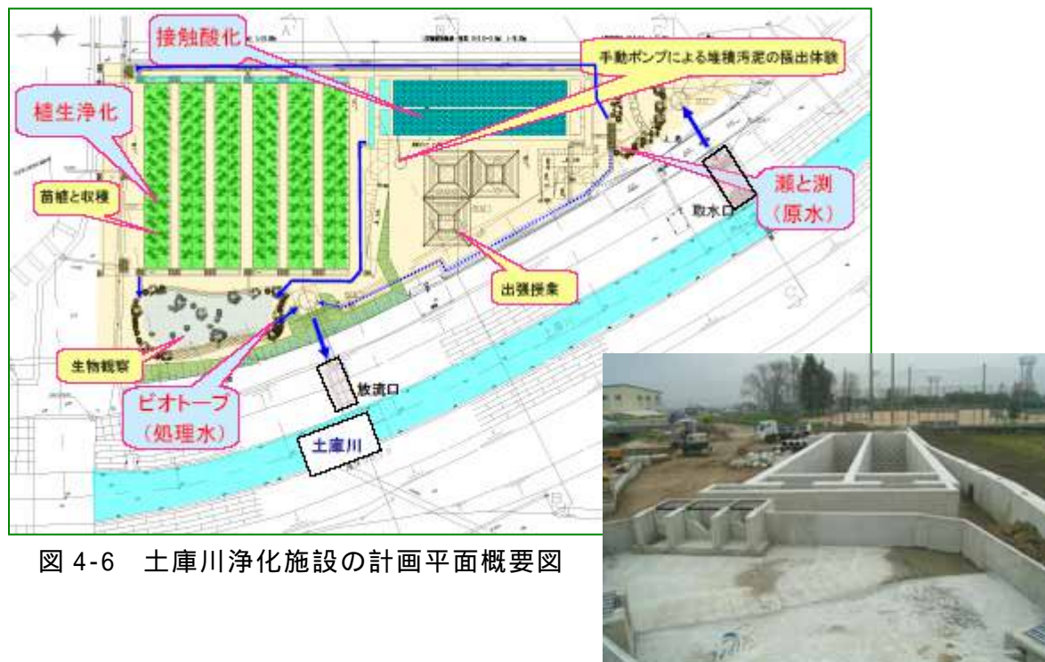
写真 工事中の土庫川浄化施設
