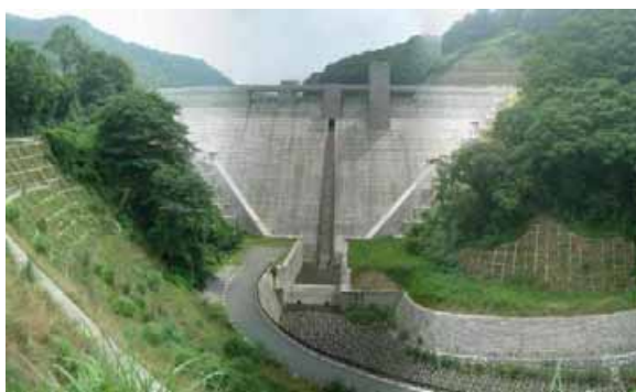
図 完成した岩井川ダム
