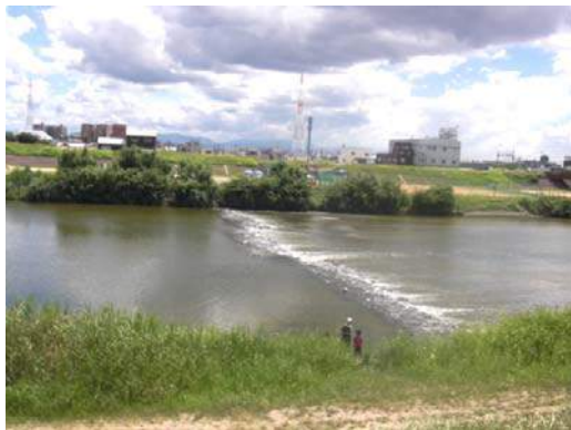
【瀬・淵浄化方式 天美矢田地区】
