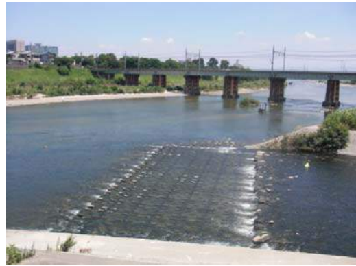
【薄層流浄化方式 西除川浄化施設】
