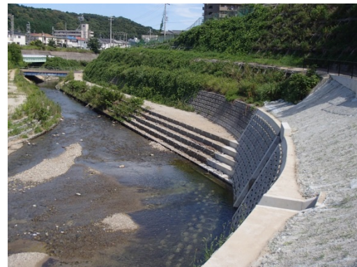
【植栽復旧状況(大阪府、天見川)】
