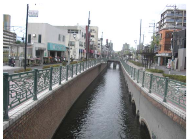
【築留用水路(柏原市)】
