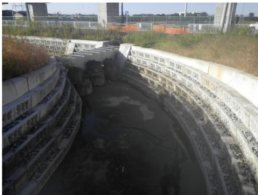
【護岸の整備状況(奈良県、蟹川)】
