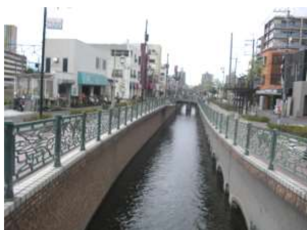
【築留用水路(柏原市)】
