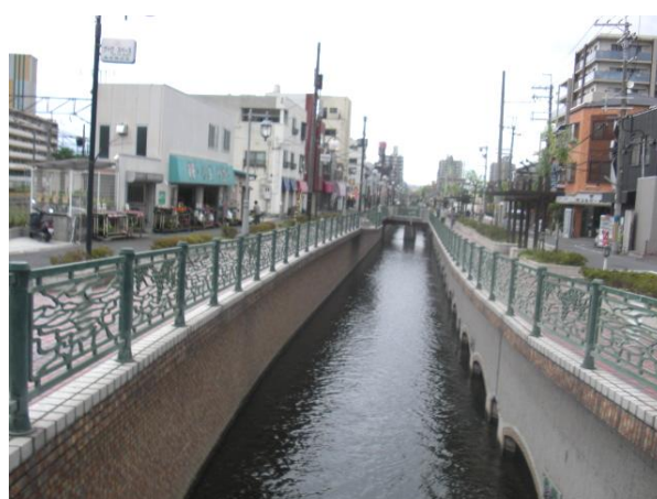
【築留用水路(柏原市)】
