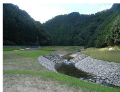
【景観に配慮した護岸整備の工事が進む飛鳥川上流(栢森地先)】
