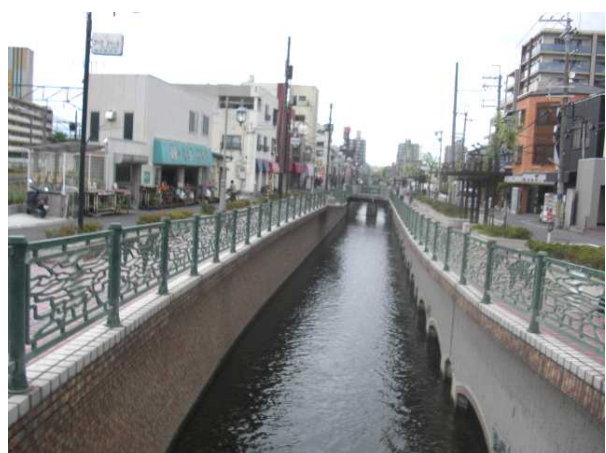
【築留用水路(柏原市)】
