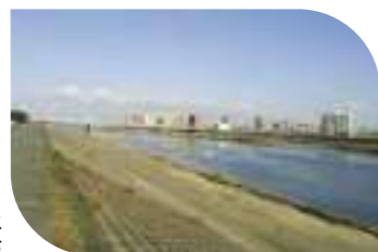
河口から約2.5キロの地点 下流をのぞむ
