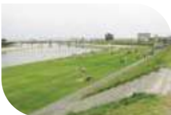
河口から約18.2キロの地点 下流をのぞむ
