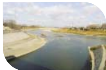
河口から約5.8キロの地点 下流をのぞむ
