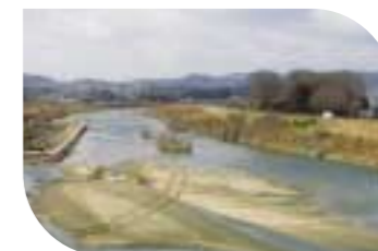
河口から約33.0キロの地点 下流をのぞむ
