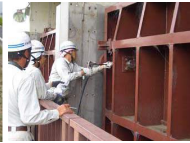
施設の点検状況
