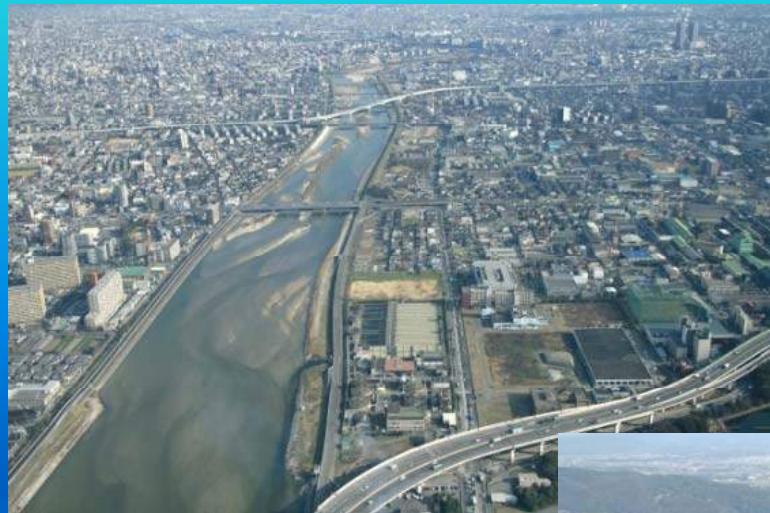
大和川 河口より2.0km付近
