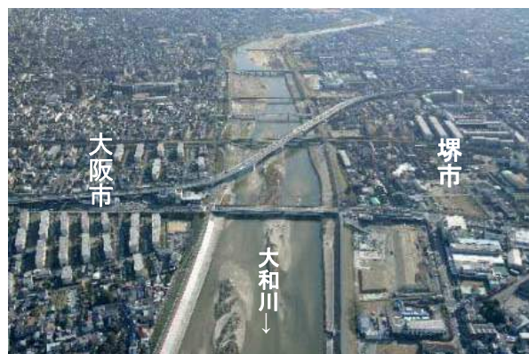
阪神高速大阪堺線橋梁付近 (大和川3.6km付近)
