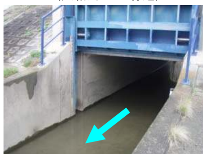
段差がなく魚類等の移動可能な水路
