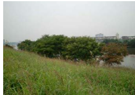
河道内樹木の繁茂状況
