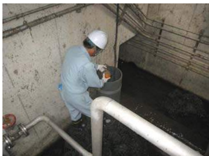
写真4.12 樋門浄化施設の設備点検
