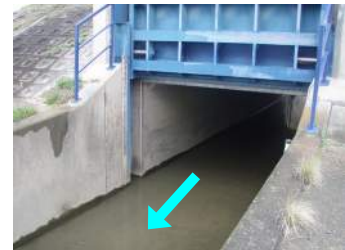
写真4.4 落差がなく移動が可能な水路 (佐保川2.3k付近 美濃川の樋門)
