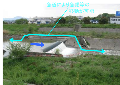
写真4.3 曾我川取水堰の魚道
