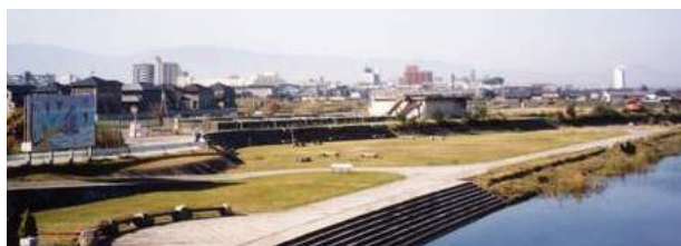
写真 2.16 初瀬川金屋河川公園
