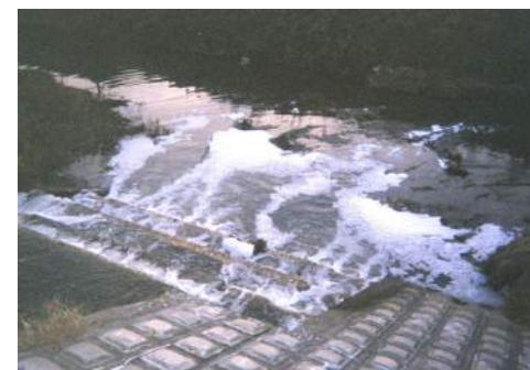
写真 2.14 飛鳥川に排水される濁水
