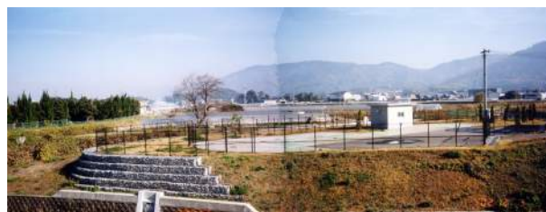
写真 2.15 三輪川浄化施設
