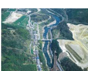
写真 1.28 亀の瀬の状況
