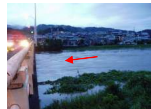
写真 1.17 藤井観測所より 右岸を望む(大正橋付近) (平成 19 年 7 月洪水)
