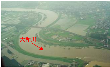
写真 1.12 河合町付近 (平成 11 年 8 月洪水)
