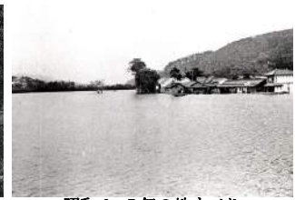
昭和 6～7 年の地すべり (大和川上流の浸水)
