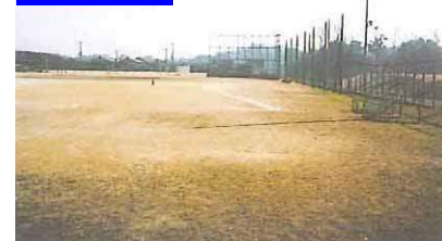
写真 1.22 雨水貯留浸透施設(広陵町立真美ヶ丘中学校)
