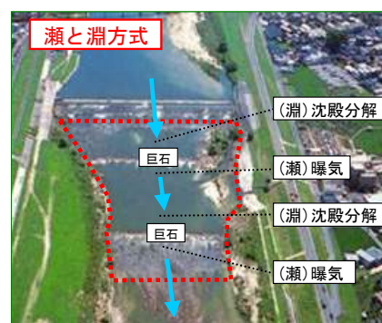
図 1.22 瀬と淵浄化施設
