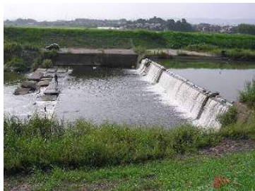
写真 2.1 堰による落差 (須原井堰、佐保川 1.3k)
