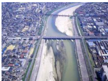
写真 1.31 下流部の状況
