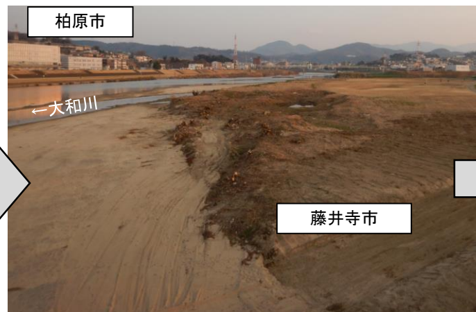
【施工後】令和4年2月撮影
