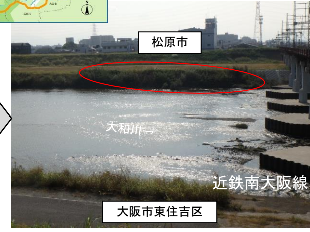
【施工後】令和4年11月撮影
