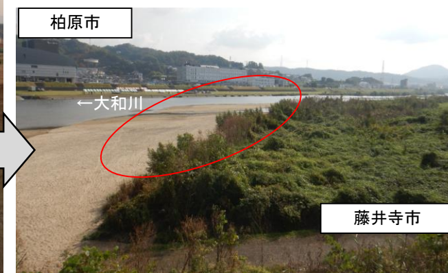
【施工後】令和4年11月撮影
