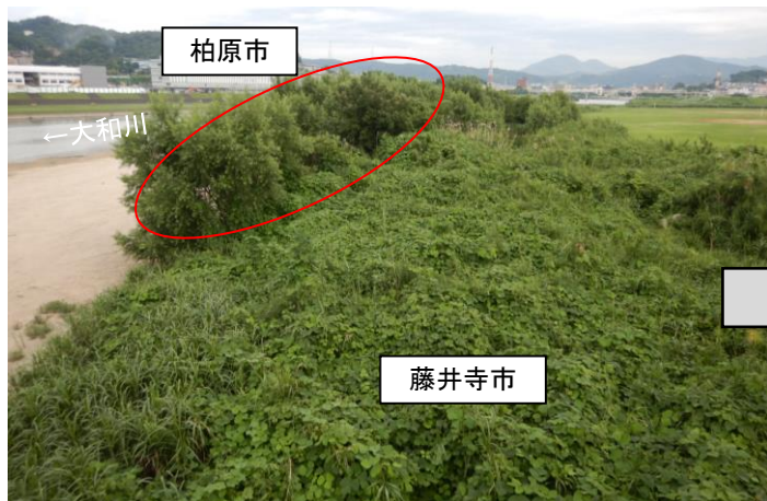
【施工前】令和3年7月撮影
