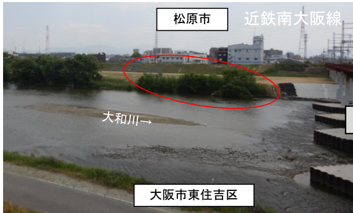
【施工前】令和2年5月撮影
