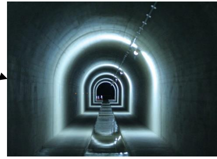
排水トンネル
