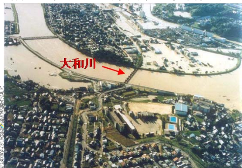
昭和57年8月洪水(奈良県王寺町付近)
