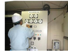
樋門浄化施設の設備点検
