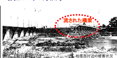
柏原市付近の被害状況
