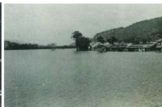
昭和6～7年の地すべり (大和川上流部の浸水)
