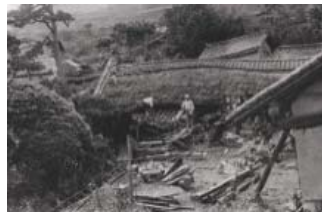
昭和6～7年の地すべり (人家の崩壊)
