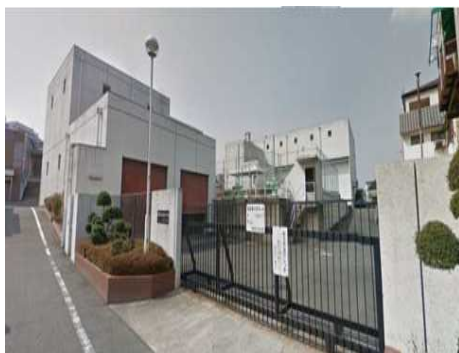
国分第2雨水ポンプ場
