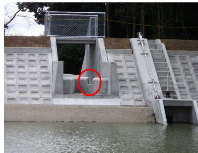
葛城市 大屋下池
