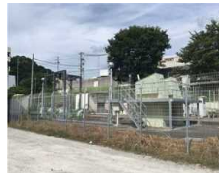
国分市場第1雨水ポンプ場
