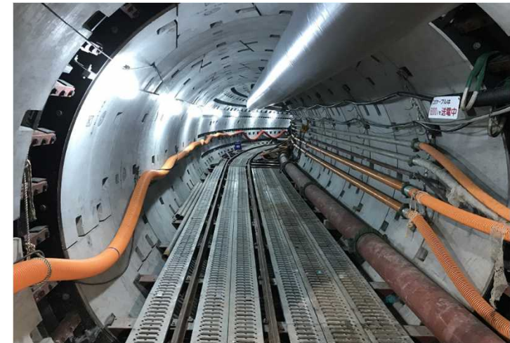
写真：施工状況（上：発進立坑 下：管きょ）
