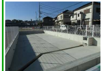
工事中の地下貯留施設 (田原本町)
