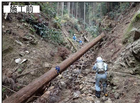
(治山ダム群の整備)
