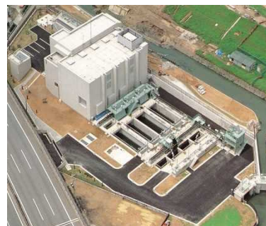
小山雨水ポンプ場
