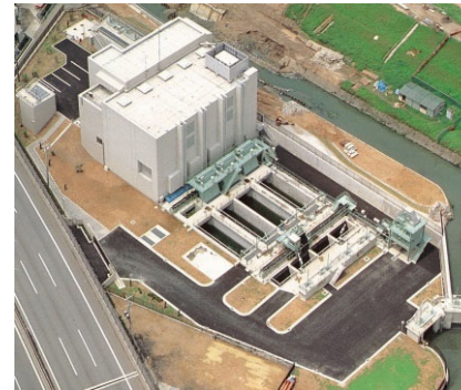
小山雨水ポンプ場
