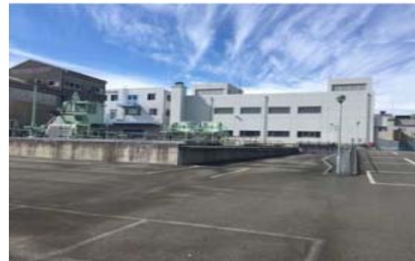
片山雨水ポンプ場
