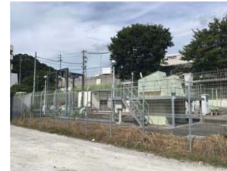
国分市場第1雨水ポンプ場
