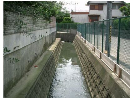
雨水幹線整備前の状況
