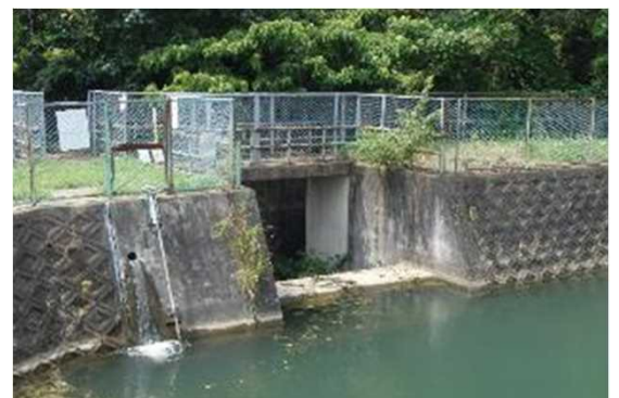
余水吐（着手前）
