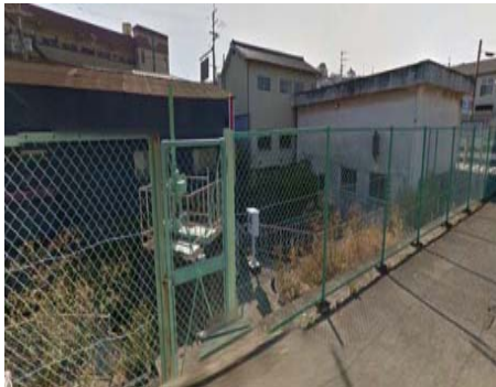
国分第1雨水ポンプ場
