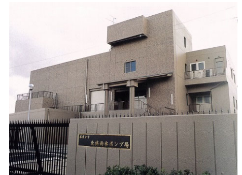
北條雨水ポンプ場
