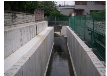
雨水幹線整備後
