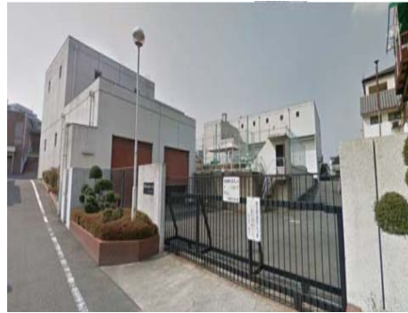
国分第2雨水ポンプ場
