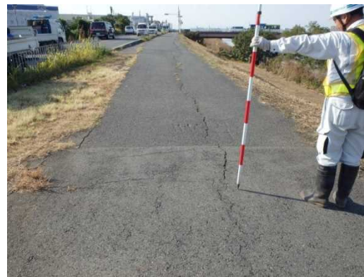
堤防天端の点検状況
