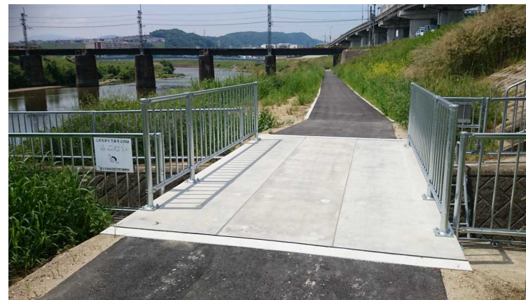
管理用通路の整備
