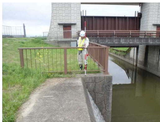
樋門の点検状況
