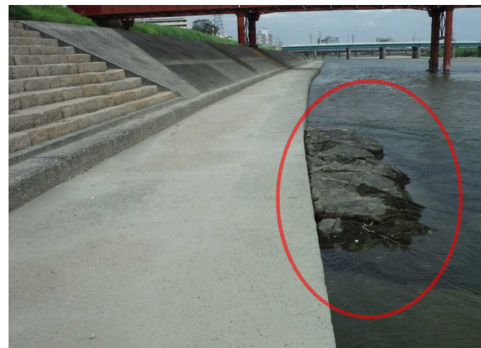
袋詰め玉石の設置
