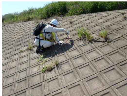
護岸の点検状況
