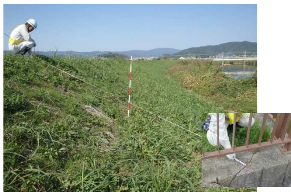
堤防法面の点検状況
