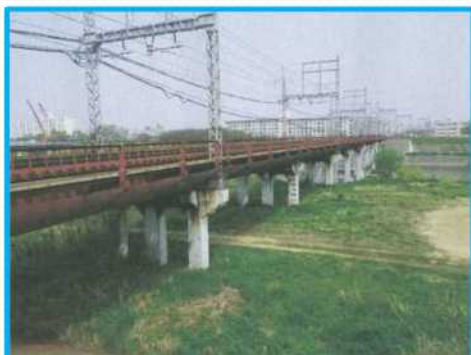
近鉄南大阪線 大和川橋梁
