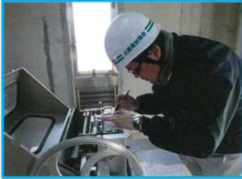
水文観測施設の点検
