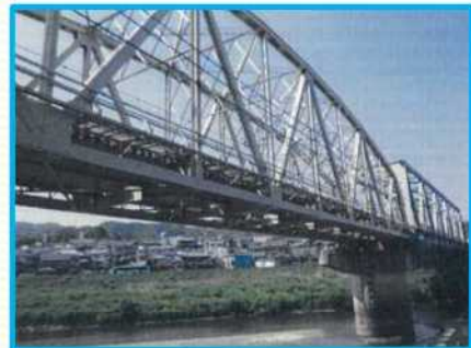
JR関西本線 第3大和川橋梁
