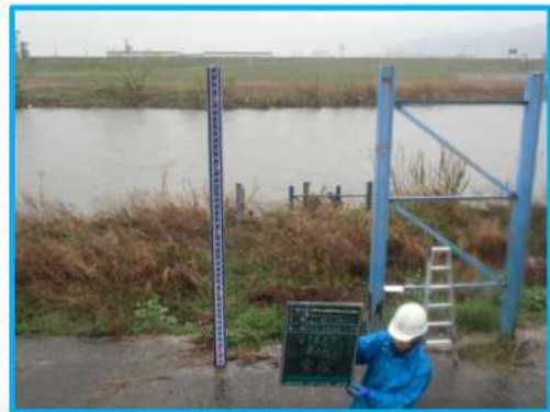
老朽化して判読しづらい量水板の取替
