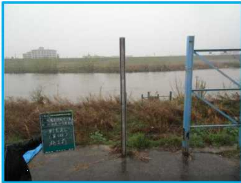
老朽化して判読しづらい量水板の取替
