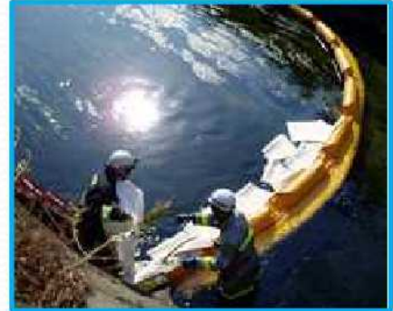
オイルフェンス・オイルマットの設置
