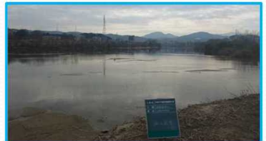
現況流下能力に支障がある土砂堆積箇所(大和川と石川の合流点付近)
