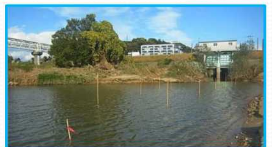
樋門等の操作に支障がある土砂堆積箇所(大和川18.8km付近・谷川樋門)
