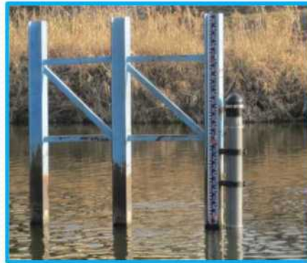
老朽化している水位計の補修
