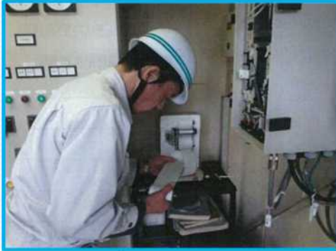
水文観測施設の点検
