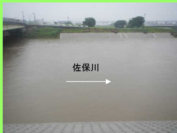
出水時(佐保川旧長安寺井堰周辺)
