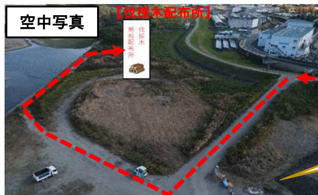
写真② 河川内仮設道路を破線のとおり進んで下さい。
