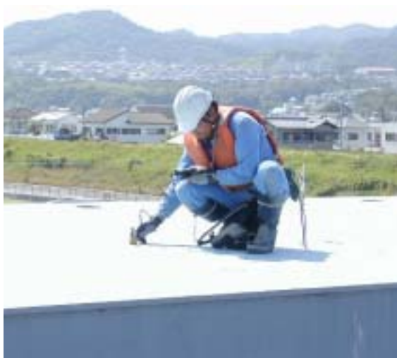
写真 3.1 反射ターゲット設置・扉体温度計測
