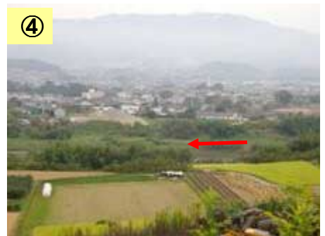
④ 築堤工事が未実施
