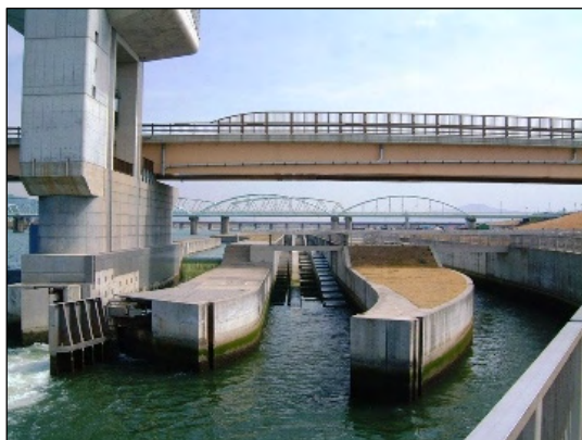
写真 2.3.6 紀の川大堰魚道（左岸 6.2k）
