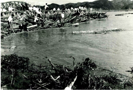
写真 1.2.3 和歌山市南海橋の被害状況 (昭和 34 年伊勢湾台風)
