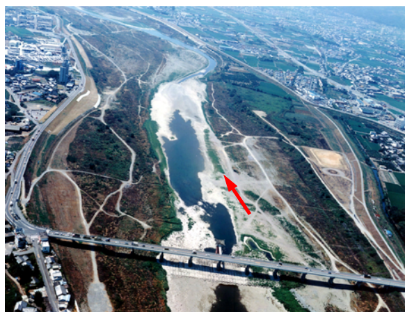
写真 2.2.1 岩出橋付近の瀬切れ (平成6年8月)
