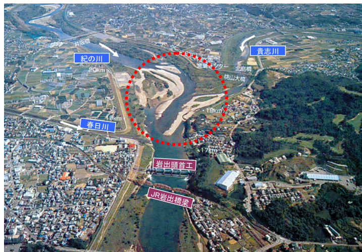
写真 2.1.1 岩出頭首工上流の土砂堆積状況
