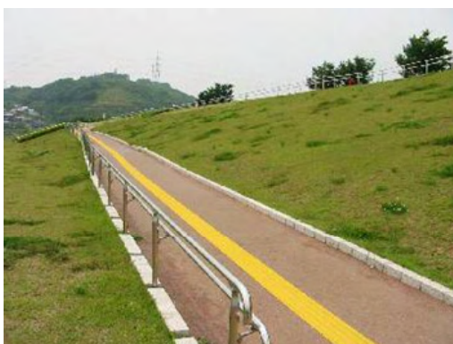
写真 4.3.2 緩勾配の坂路
