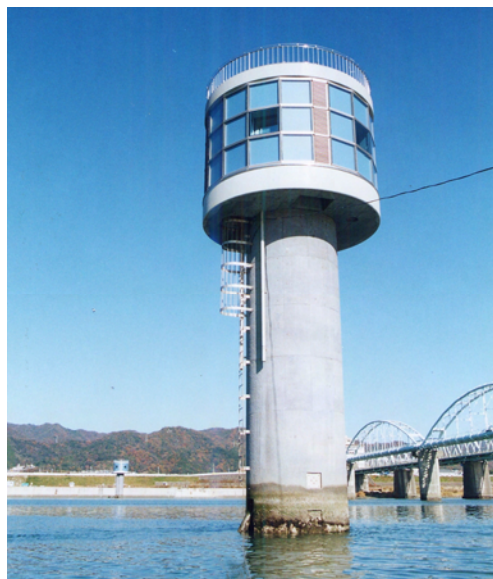
写真 2.4.6 紀の川大堰-水質監視
