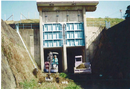
樋門周辺の土砂撤去
