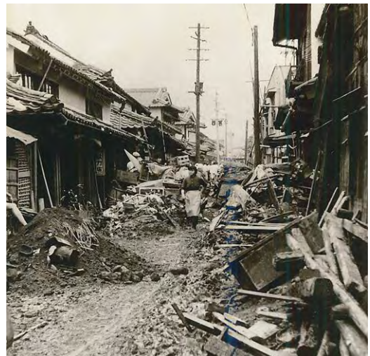
写真 1.2.4 奈良県五條市の被害状況 (昭和 34 年伊勢湾台風)
