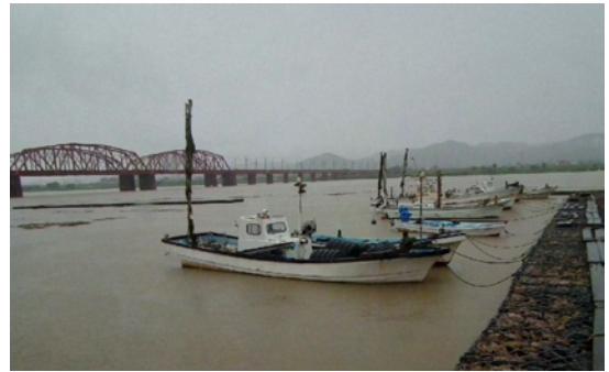
写真 2.3.14 不法係留の状況（左岸 3.6k 付近）
