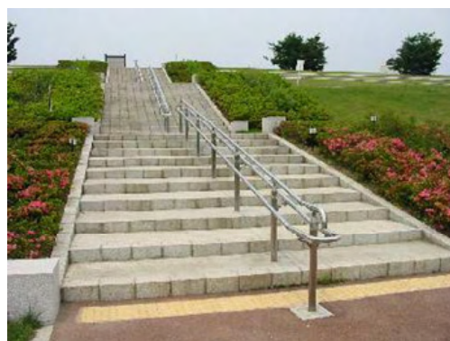
写真 4.3.3 手すり付きの階段
