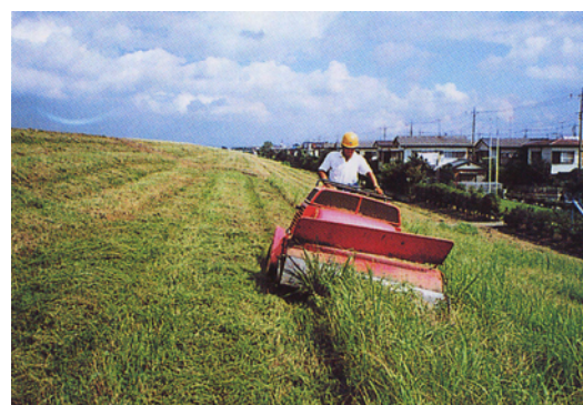
写真 2.4.1 堤防の除草状況
