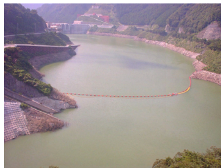
写真 4.4.8 網場設置の様子（大滝ダム）
