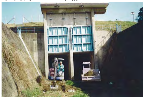
樋門周辺の土砂撤去
