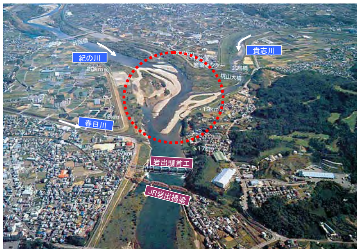
写真 2.1.1 岩出頭首工上流の土砂堆積状況
