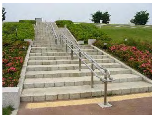
写真 4.3.3 手すり付きの階段
