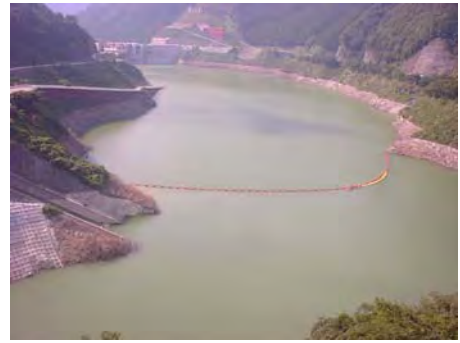
写真 4.4.8 網場設置の様子（大滝ダム）
