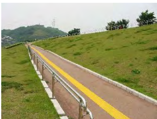
写真 4.3.2 緩勾配の坂路
