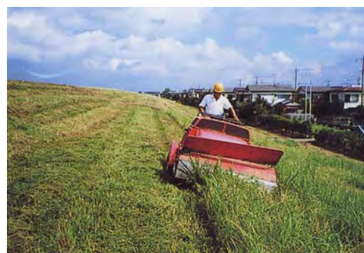
写真 2.4.1 堤防の除草状況
