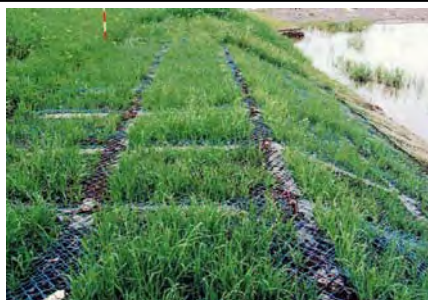
多孔質な水際空間の創出や水際空間の緑化等による生態系に配慮した護岸補修
