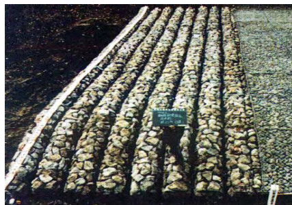
木や石などの自然素材を用いた伝統工法等を採用することによる良好な水辺景観に配慮した護岸補修
