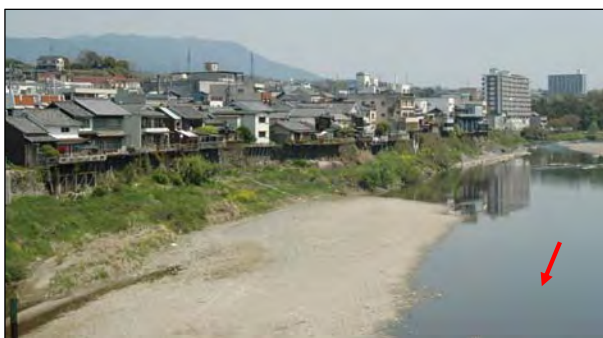
写真 4.3.4 整備前（橋本橋直上流）
