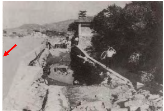
写真 1.2.2 県道海南九度山線：麻生津 あうづ ～竜門間の被害状況 (昭和 28 年台風 13 号)
