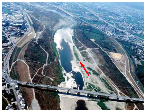
写真 2.2.1 岩出橋付近の瀬切れ (平成6年8月)
