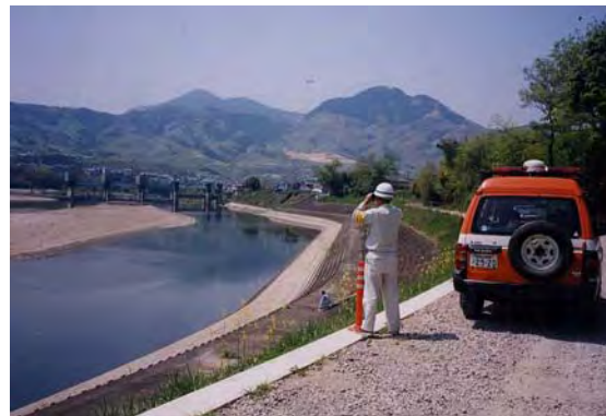
写真 4. 4. 5 河川巡視の様子
