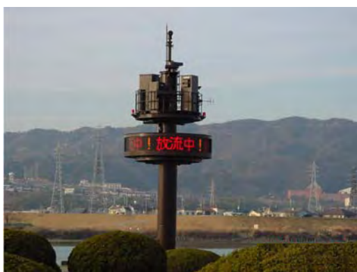
写真 4.4.6 紀の川大堰警報局及び電光表示板
