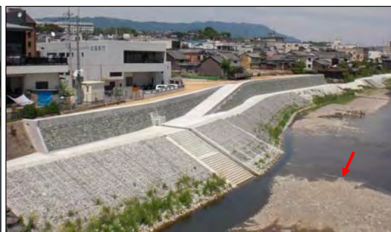
写真 4.3.5 整備後（橋本橋直上流）
