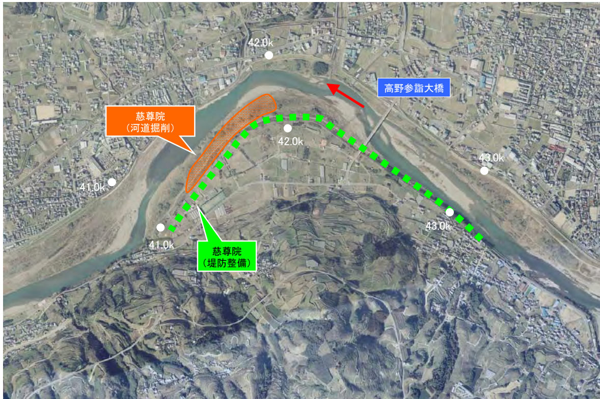
写真 4. 1. 4 河道の整備（和歌山県九度山町）
