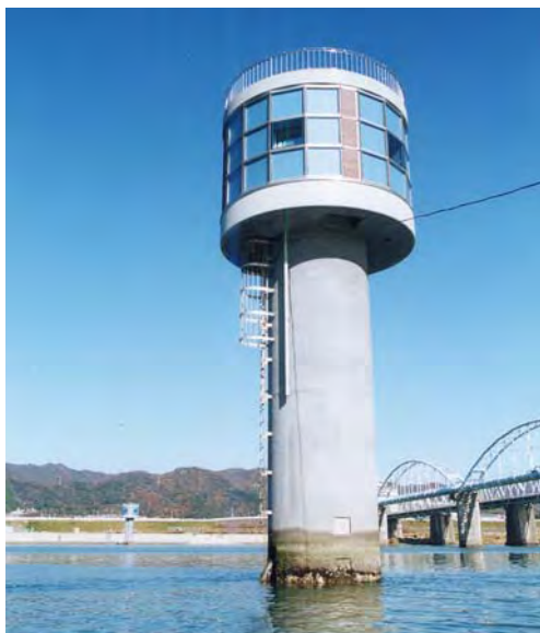
写真 2.4.6 紀の川大堰-水質監視
