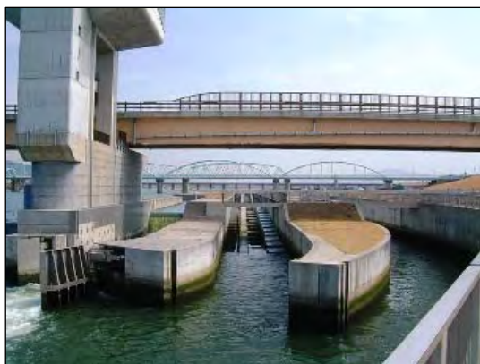
写真 2.3.6 紀の川大堰魚道 (左岸 6.2k)
