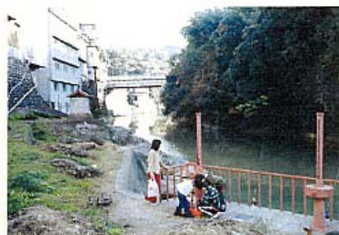
写真 1.5 九度山地区の紀伊丹生川の河川敷に張り出した住宅
