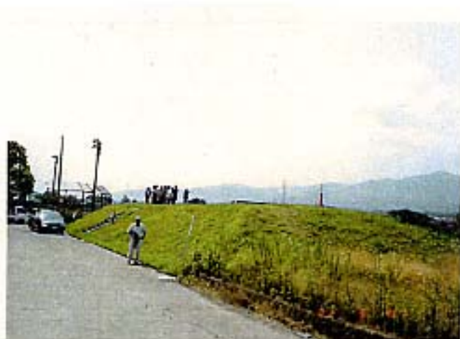
写真 1.6 安田嶋地区のし尿処理場の近くの 樋門が造られた場所の堤防
