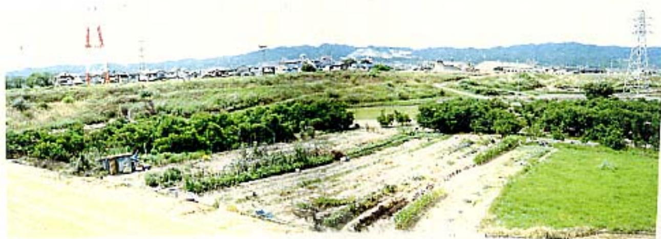
写真 1.12 春日川合流部上流右岸地区の堤内地の状況
