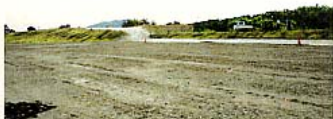
写真 1.10 嶋地区の工事中の堤防
