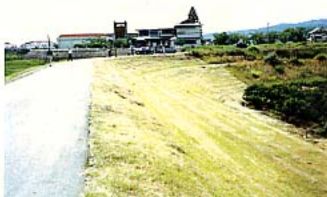
写真 1.11 春日川合流部上流右岸地区の下流側の堤防
