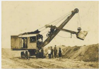
紀の川の工事で使われた機械 (昭和4~5年頃の撮影)
