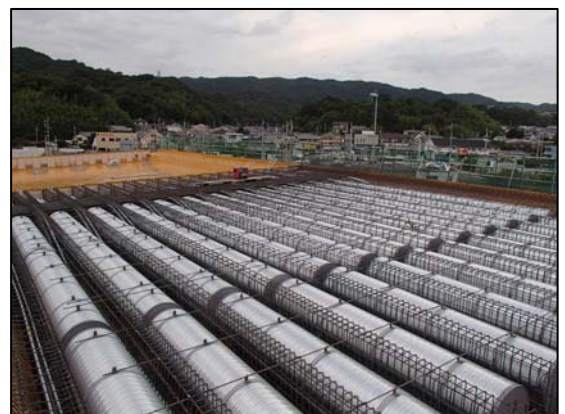
現場状況(平成25年9月6日現在)
