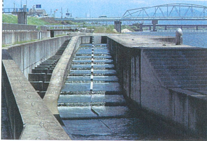
アユの遡上が確認できた右岸階段式魚道
