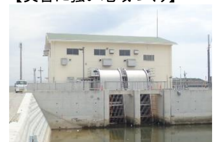
排水機場の改修 (写真はイメージ)
