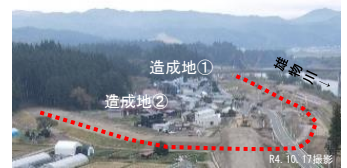
移転家屋の建設が進む状況
