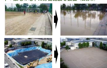
上：校庭周囲に設置した小堤による貯留（兵庫県） 下：敷地の地下に貯留施設を設置（西宮市）
