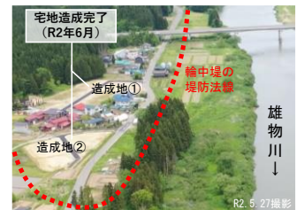
移転先宅地造成完了状況
