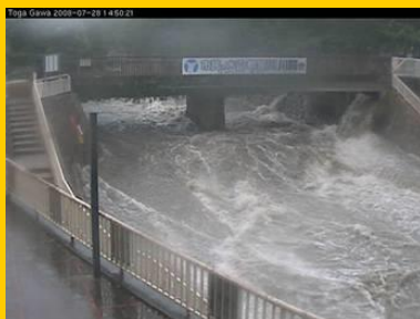
写真3.2008年7月28日都賀川甲橋の様子（前10分間で約1.3m水位が上昇） (出典：片山ら,2015)
